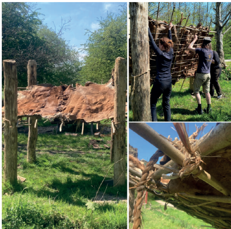
Fig. 3. Taget bliver til. T.v.: Det færdige tag. Det gik ikke vores næser forbi, at tagets lethed stod i stærk kontrast til stolpernes solide karakter. Vi ændrede hældningen efter billeder blev taget i et forsøg på at få vandet til at løbe over sammensyningen i stedet for igennem. Det gav en minimal forbedring. T.h. øverst: Taget vippes og rejses. Det er let nok til at ændre på relativt hurtigt. T.v. nederst: Nærbillede af sammenbindingerne. Ønsker man at ændre eller tilføje er konstruktionen lige til at "binde op". Fotos: Camilla Fraas Rasmussen & Henriette Lyngstrøm.
